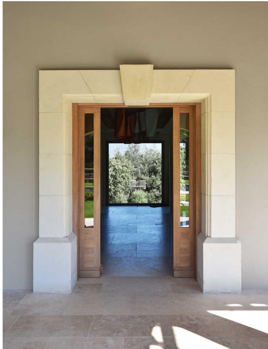
Encadrement en pierre de Rambé, légèrement coquillée. Socles évidés en L, avec une clé de voûte en saillie. Finition poncée.
